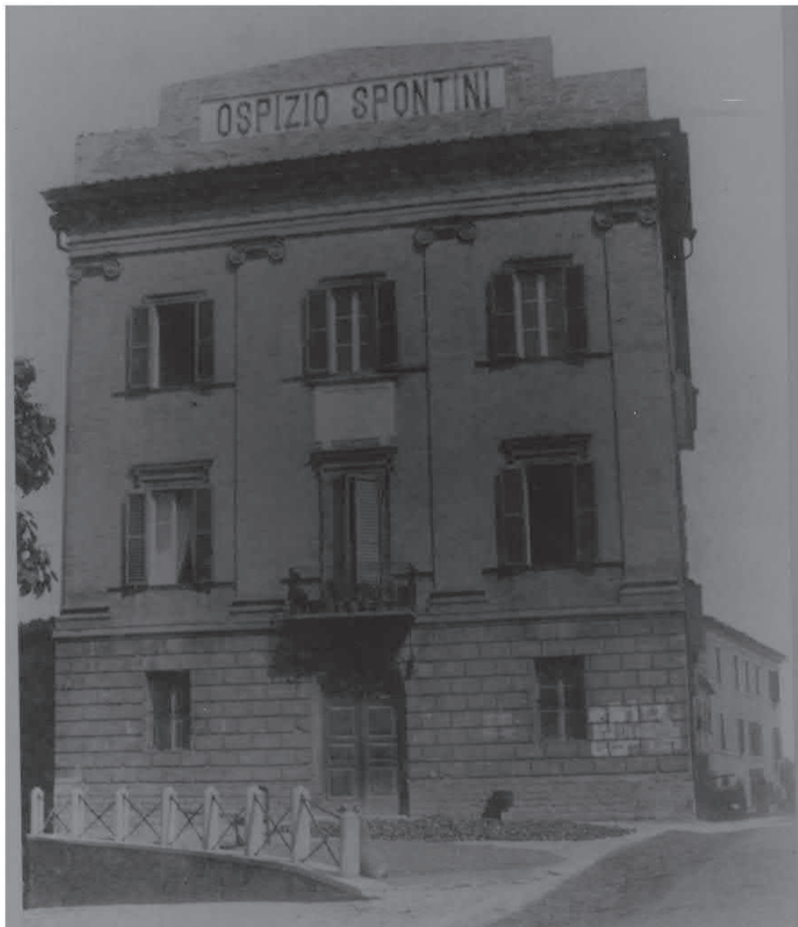
Di fronte alla casa dei coniugi Spontini che ospita attualmente l'Archivio, Biblioteca, Museo Gaspare Spontini, sorge l'edificio dell'Ospizio di Carità fondato dal compositore delle Metamorfosi di Pasquale. La Casa di riposo per anziani è in attività ed è ancora oggi gestita dalle «Opere Pie», create da Spontini nel 1843.
